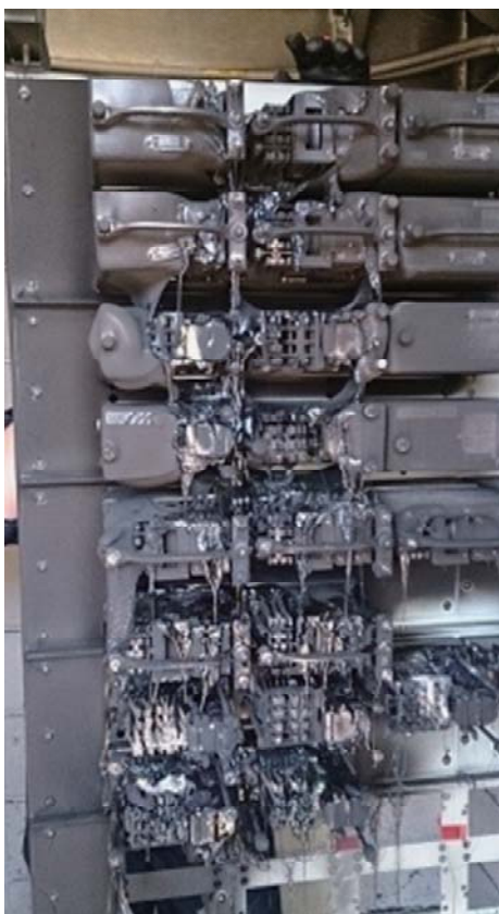
燃えてどろどろになった制御機器
